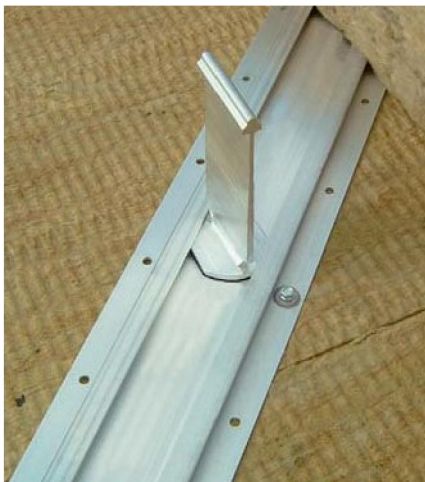
Kalzip DuoPlus otočná klipsa v kotevních profilech Kalzip DuoPlus, předvrtaných Rozměry: 120 x 6000 mm
