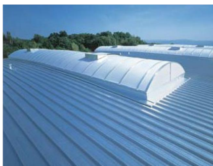
Tělocvična gymnázia Vallendar (D) po rekonstrukci Architekt: Guido Fries Architekten
