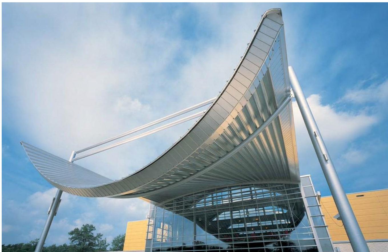
Nemocnice, Emmen (NL) Architekt: A/d Amstel Architecten
