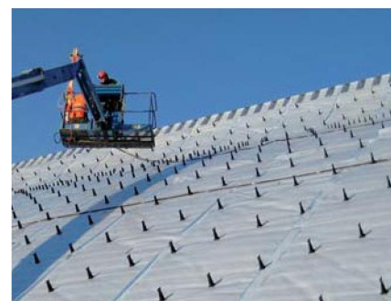
Kalzip AluPlusSolar montovaný na kompozitní klipsy
