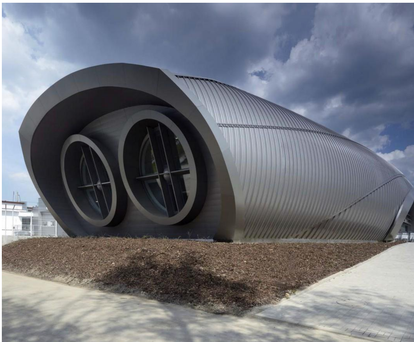
Letiště Karlovy Vary, Česká republika Architekt: Ing. arch. Petr Parolek
